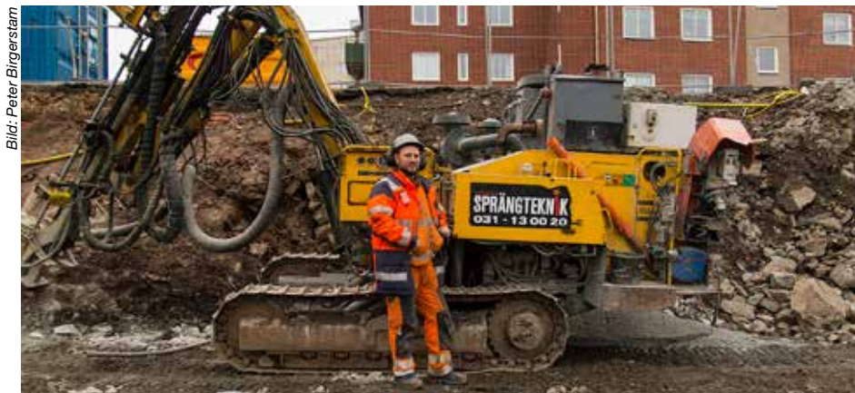
Robert Johansson, bergarbetare och delägare i Göteborgs Sprängteknik AB, mötte många utmaningar i arbetet med Brf Viva.
